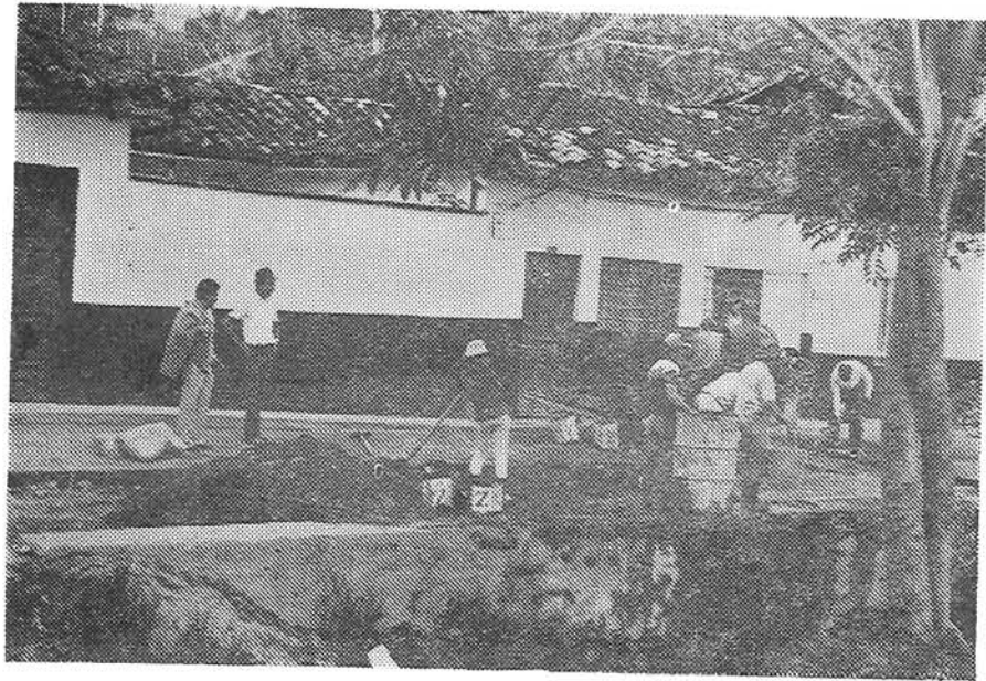
Pavimentación de la salida a Bodegas. (Foto cortesía Javier Echeverri).
