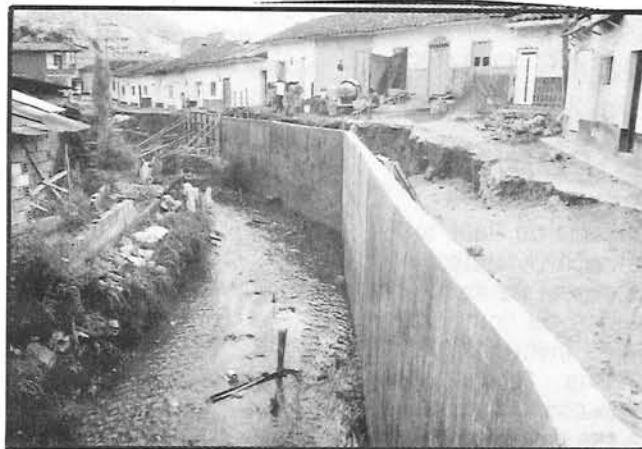
Aquí podemos observar el muro de contención construido por Cornare sobre la quebrada Bodegas cerca al puente del Centenario.
