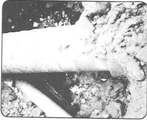
Aquí medio se puede apreciar el atanor de 24 pulgadas reventado para pasar el tubo del acueducto
