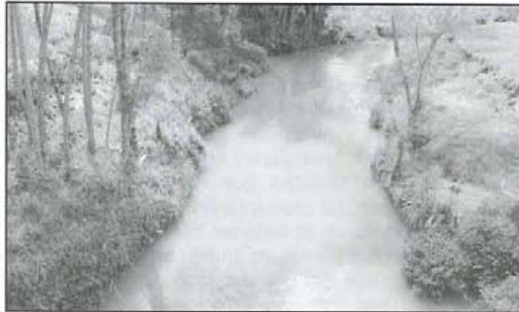
Obras de protección de La Marinilla. Todos debemos cuidar su cuenca.
