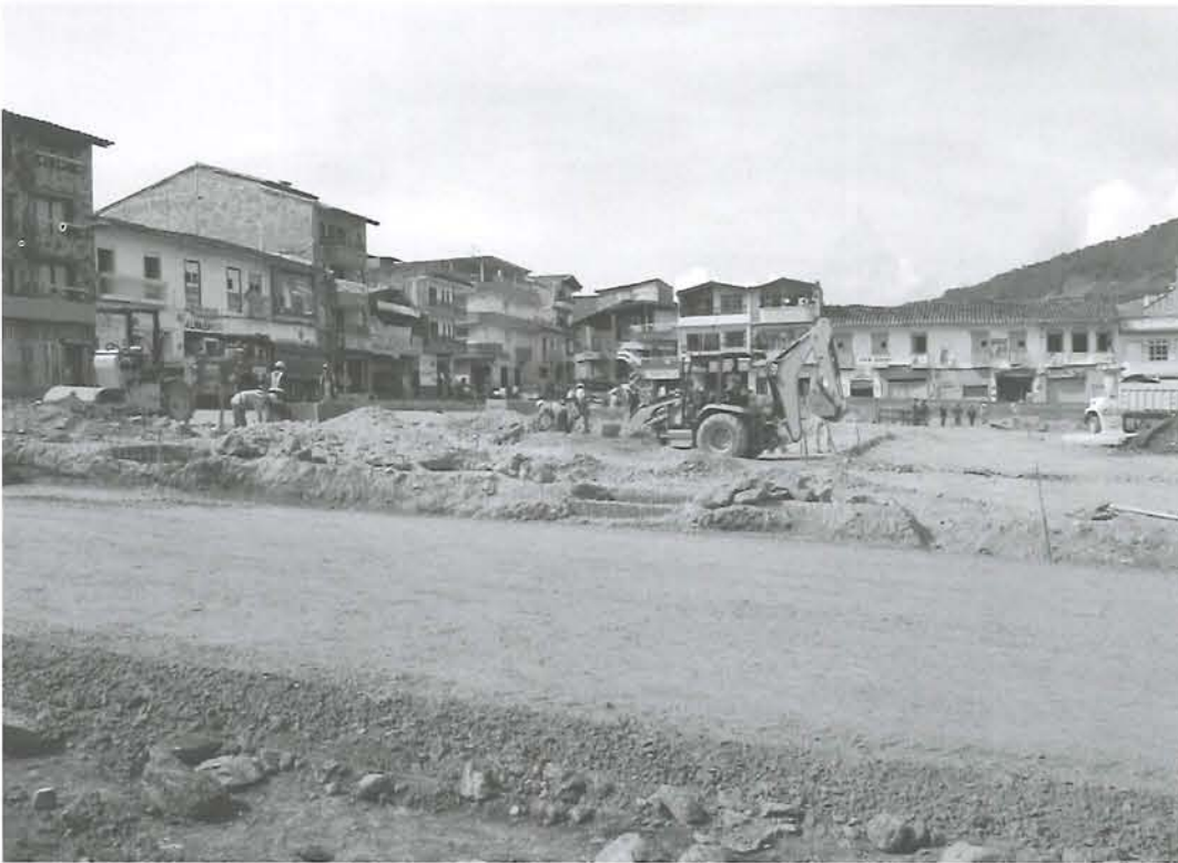
Afirmado de las zonas viales.
