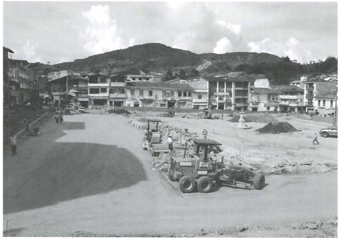
Luego de poner el material de la sub base comenzara la puesta de los adoquines y del amoblamiento.
