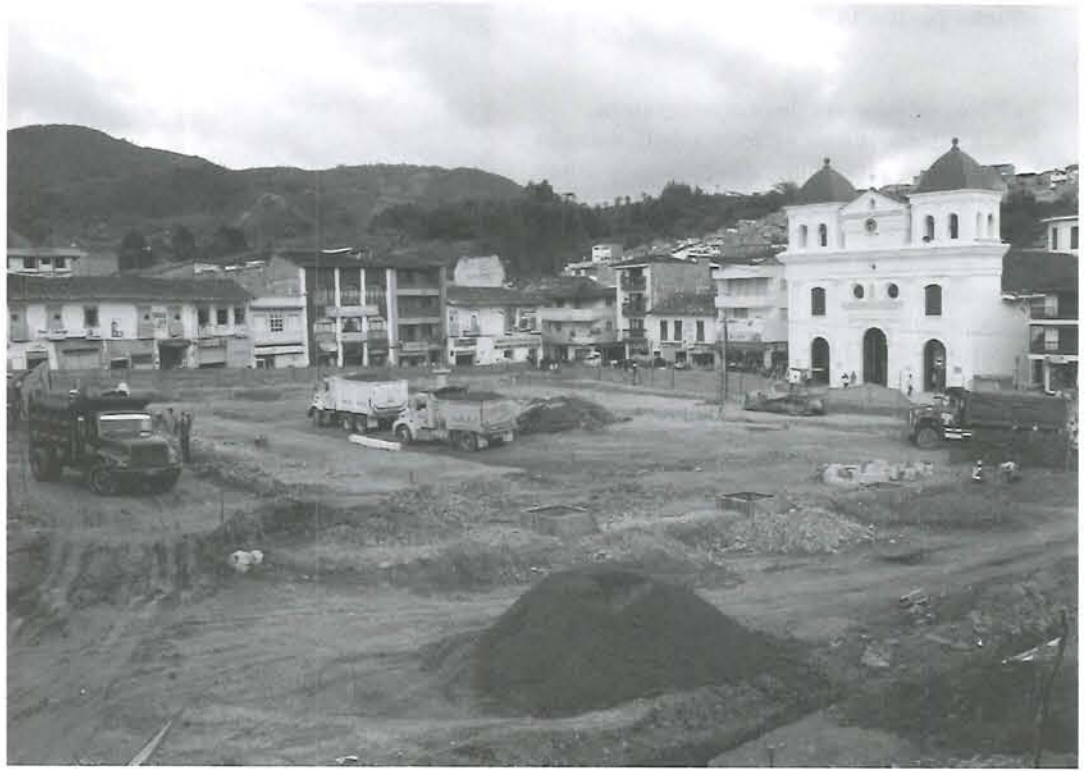
Acondicionamiento de los terrenos para el adoquinado.
