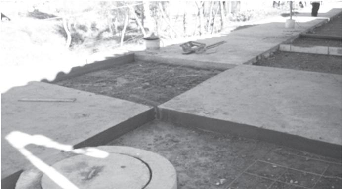
Reposición del pavimento rígido en la calle 53, que se vio afectada por la construcción del colector Bodegas por valor de \$9.258.500
