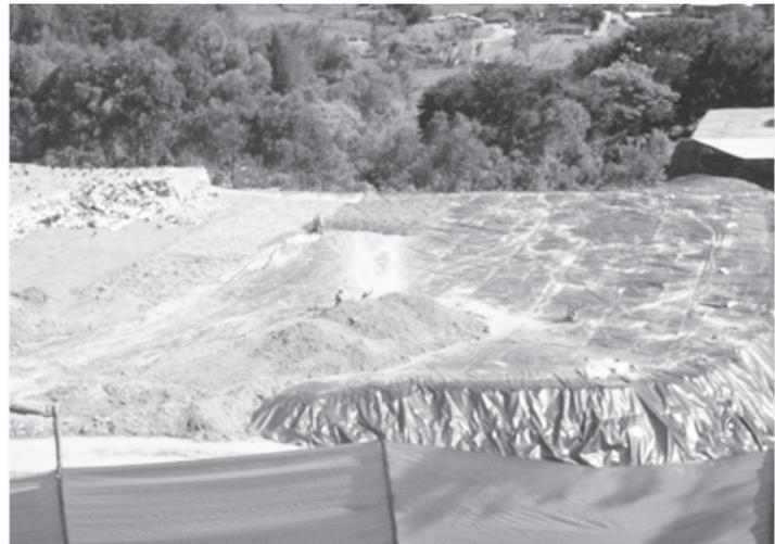
Impermeabilización con geomembrana lisa de 30 mill de 4000 m<sup>2</sup> de plataforma de disposición final en el Relleno Sanitario evitando la contaminación de los suelos y de las fuentes hídricas. Por un valor de \$57.007.098.
