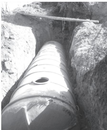
Construcción de la Planta de tratamiento de lodos en la planta de agua potable. Con una inversión de \$151.321.349.
