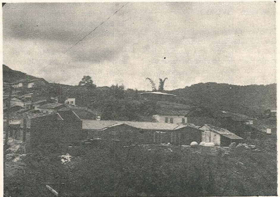
Así han quedado paralizados los trabajos en la construcción del nuevo hospital.
