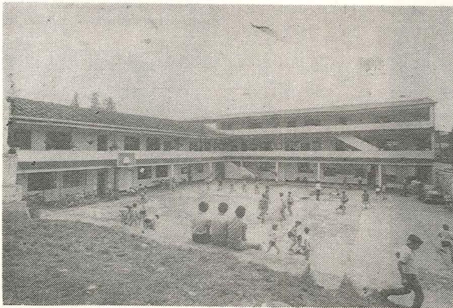
INTERIORES DEL EDIFICIO DEL COLEGIO.
