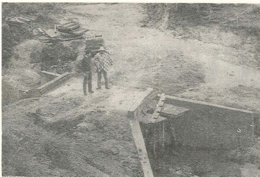
ASPECTO DE LA OBRA DEL PUENTE.
