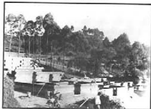
Construcción de viviendas de la Sociedad San Vicente de Paúl
