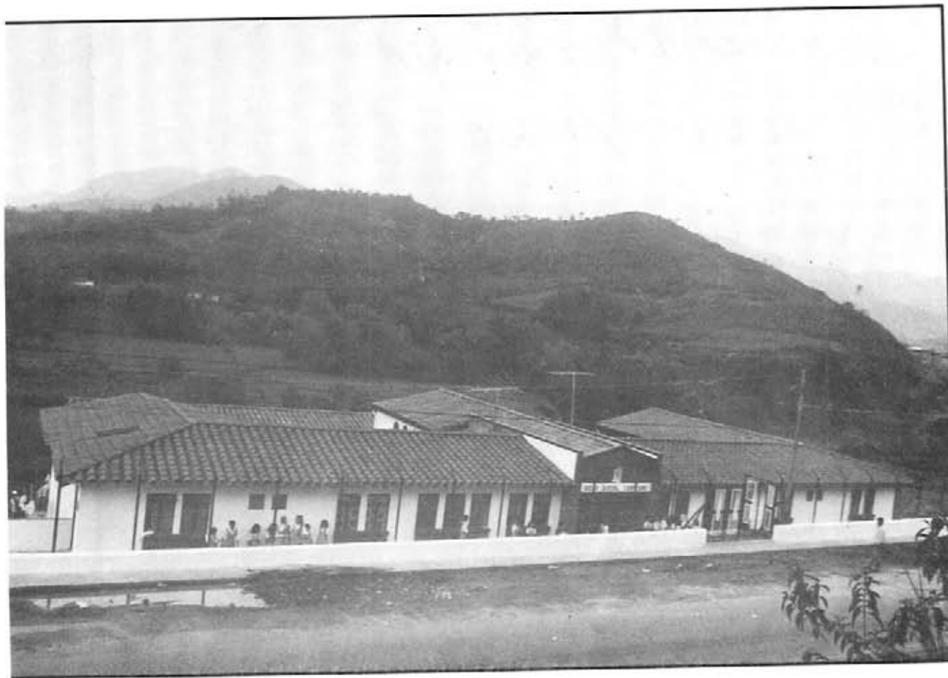
Aspecto exterior del nuevo edificio del Hogar Juvenil Campesino, inaugurado solemnemente el pasado 31 de Marzo.
