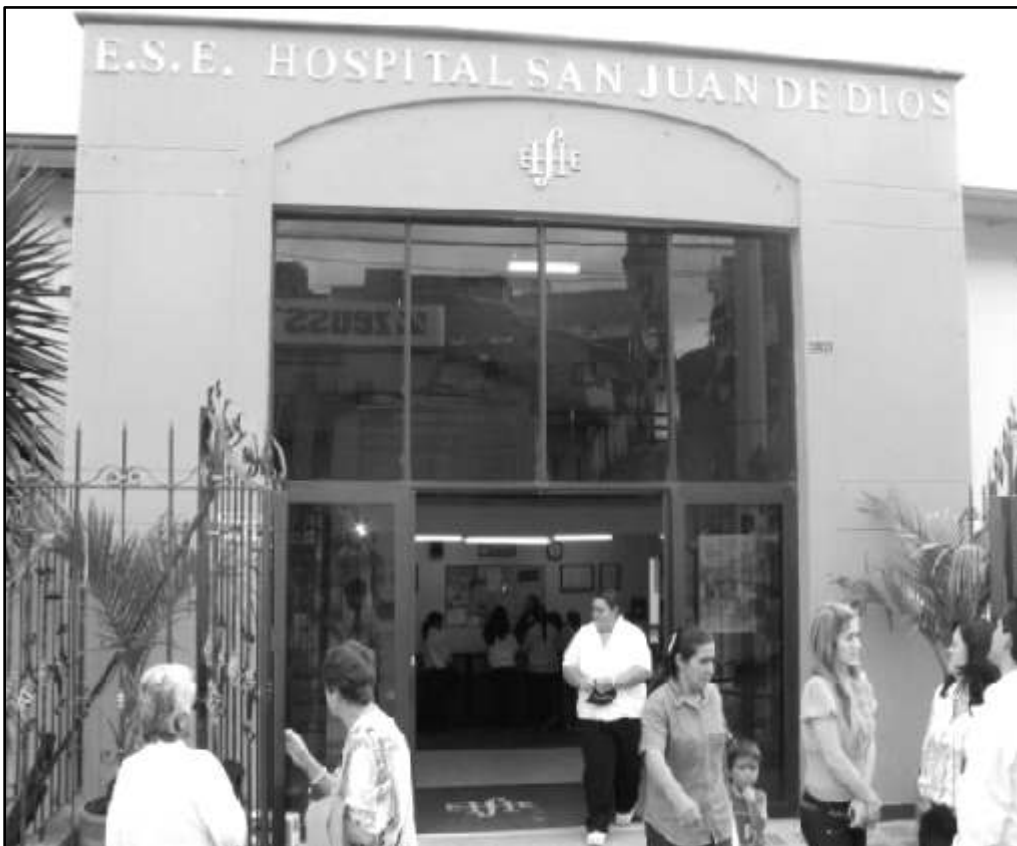
Mejoran los servicios del hospital San Juan de Dios.
