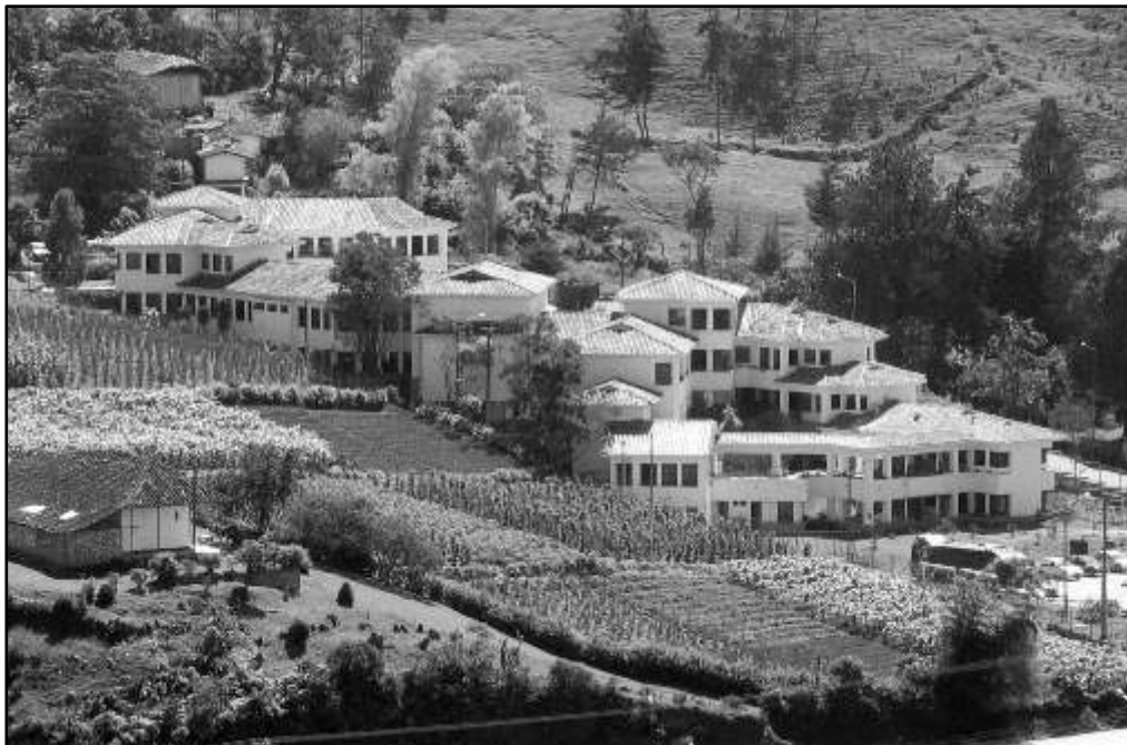
Vista panorámica de las instalaciones de Cornare.
