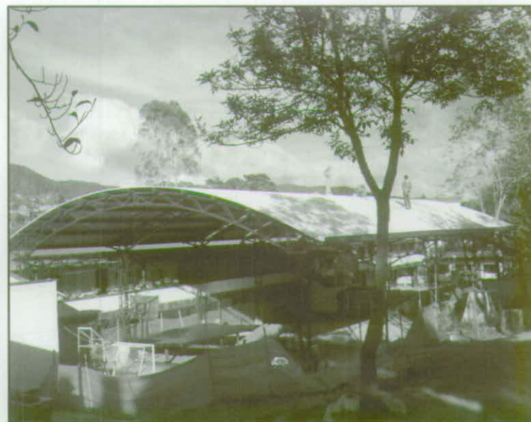
Construcción de Cubierta - Sede Eusebio María Gómez.
