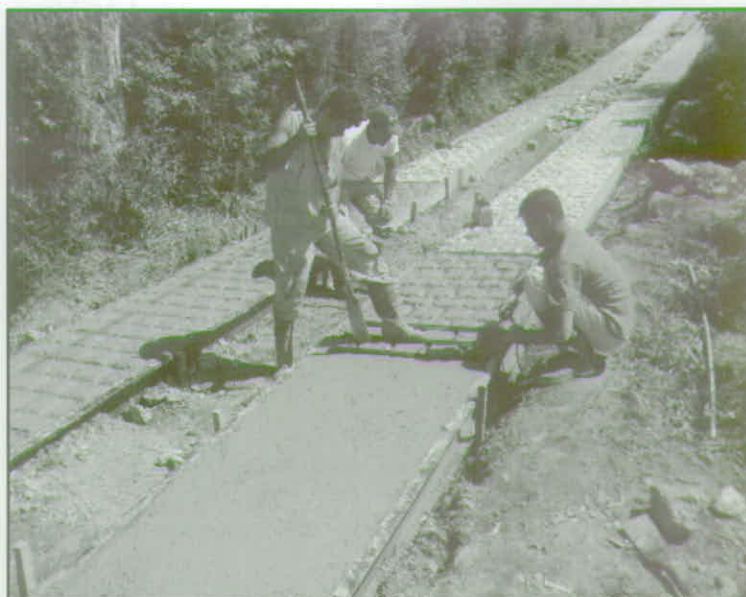
Construcción de Rieles en la Zona Rural.
