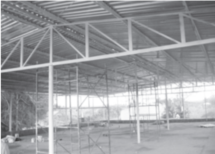
Construcción para almacenamiento de residuos sólidos
