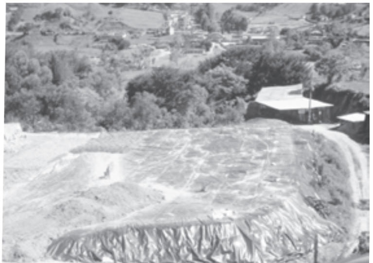
Adecuación del relleno sanitario
