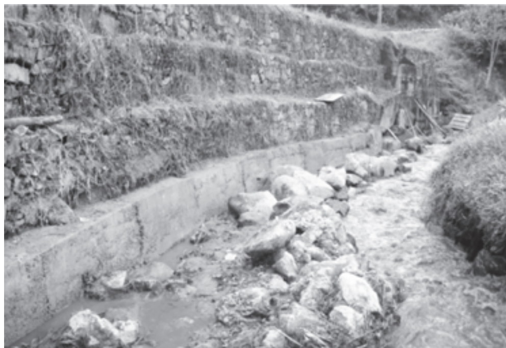
Obras en la quebrada Bodegas
